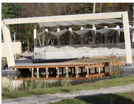
Amfiteatr w budowie
