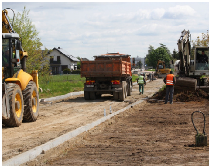
Budowa dróg na os. Leśna
