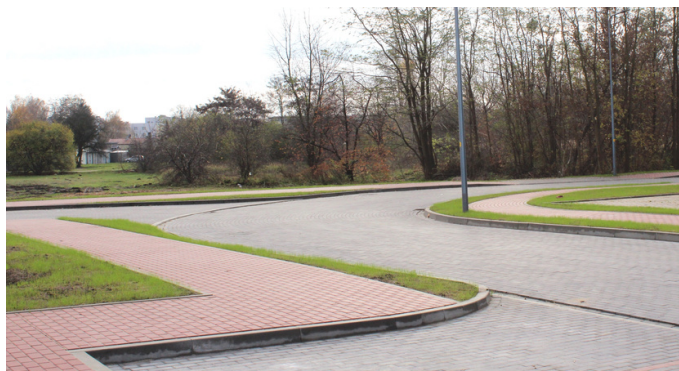
Droga 6 KDD z nową nawierzchnią
