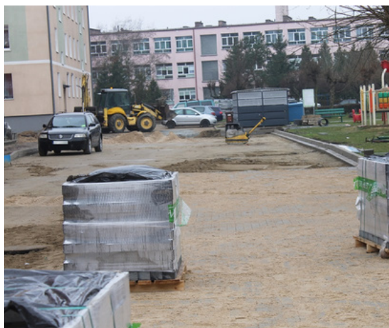
Budowa ulicy Kączkowskiego
